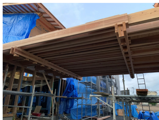
ピロティの架構は現しとする。スパン方向の部材相互の先端位置下部に直行させる部材は長屋門の棧梁を彷彿させる
