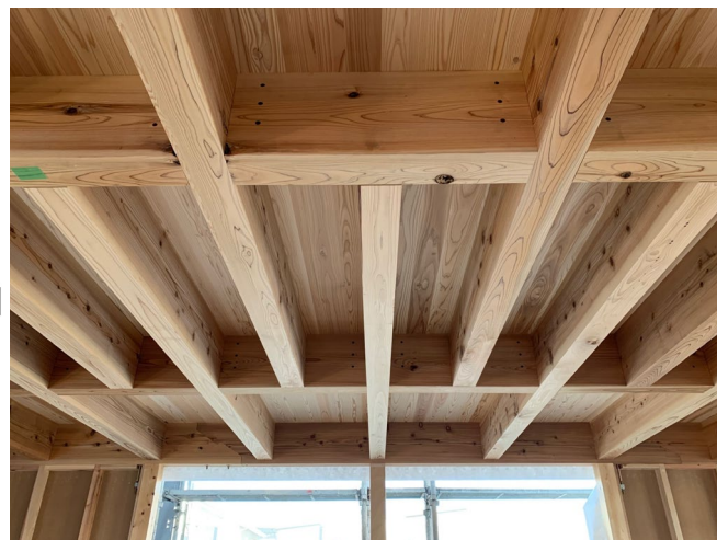
リズムカルでダイナミックなレシプロカル構造の床組み。金物設置部分のスリットが見えないよう加工を工夫した
