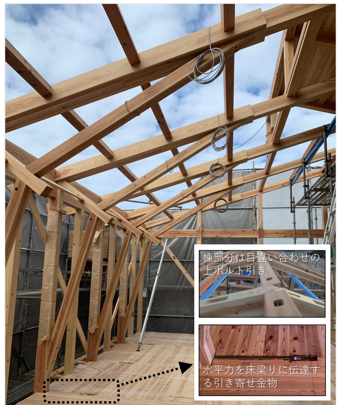
鉛直力と水平力に耐える仕組み (図：株式会社山田憲明構造設計事務所)
