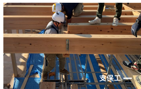
スパン中央部に支保工（写真右下）を設置し、金物部分の梁は下部より差込む
