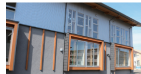
耐久性とデザインを両立した外装 鋼板とモルタルを組合せた外壁 1Fのみ杉赤身材の木製見切を配置
