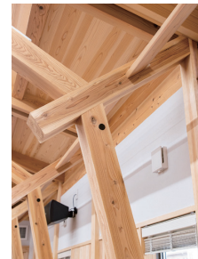
〈2F 大会議室〉 6間スパンを支える 多角形アーチ構造 横架材は長浜、米原、 高島など滋賀県北部 の杉材
